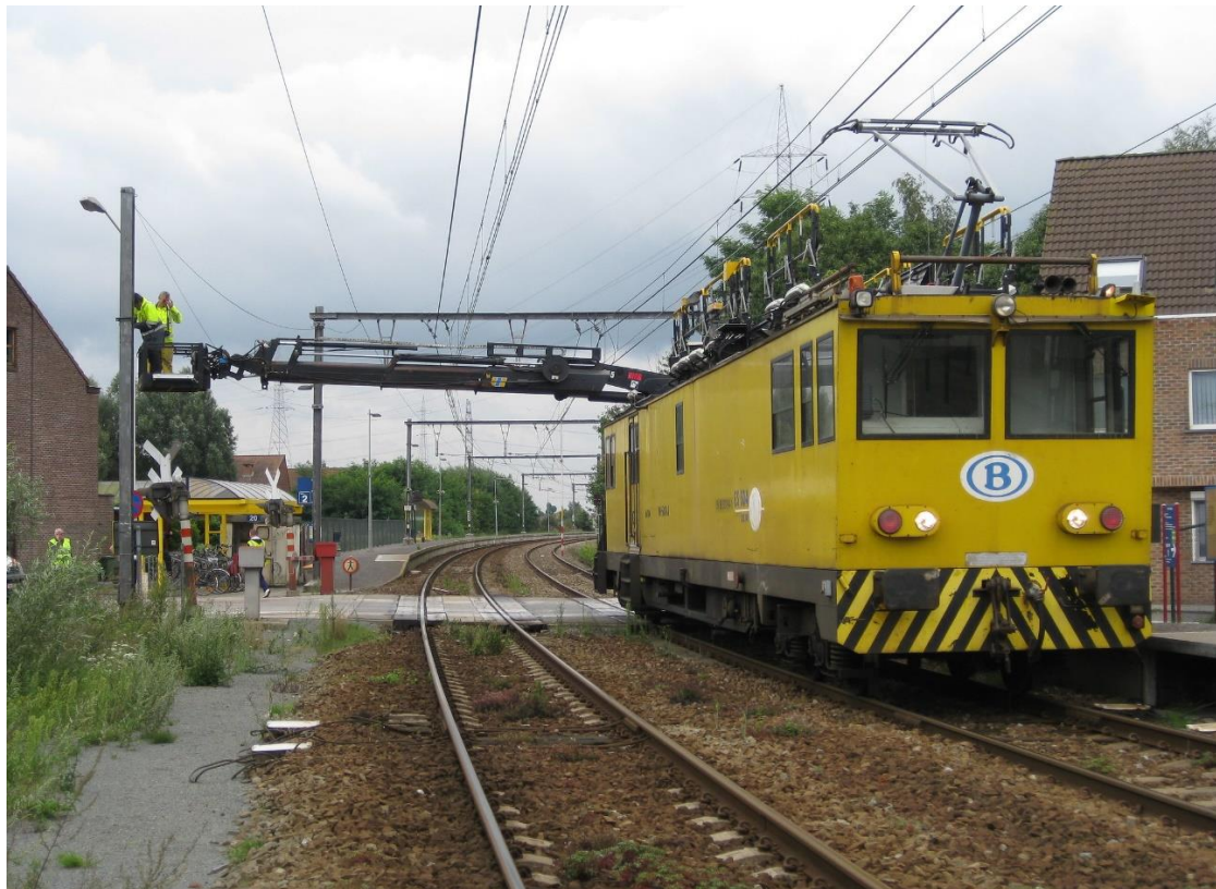
De ES 504 in volle actie bij herstellingswerkzaamheden in Schelle. 17.08.2010 Foto: Lars Laenen
