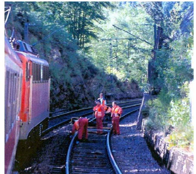
Op de Schwarzwaldbahn mag in het spoorwisselbedrijf worden uitgeweken naar het rechter spoor. In deze bedrijfstoestand kunnen zowel treinen als ook bouwplaatsen worden gepasseerd.
