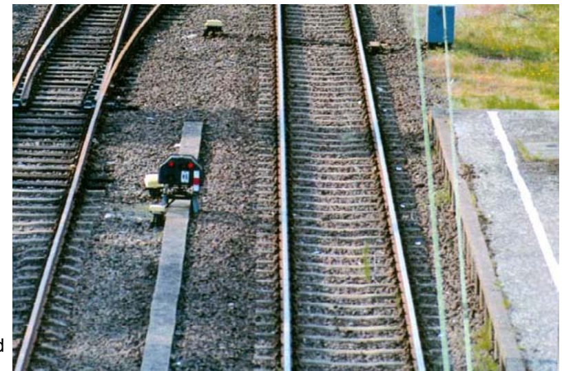
Omdat er op het linker spoor geen treinen vertrekken, is hier één spersein voldoende.
