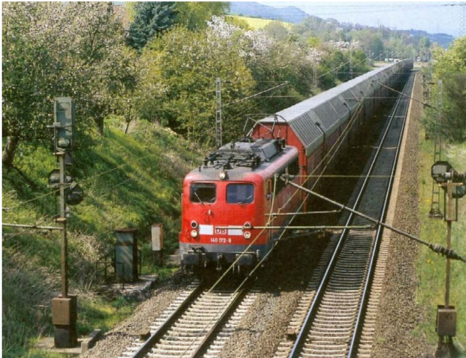
De plaats van het sein in de glooiing is ook voor modelspoorders interessant. Hier zijn het sein en de telefoon op beton geplaatst en onlangs van nieuwe ballast voorzien.
