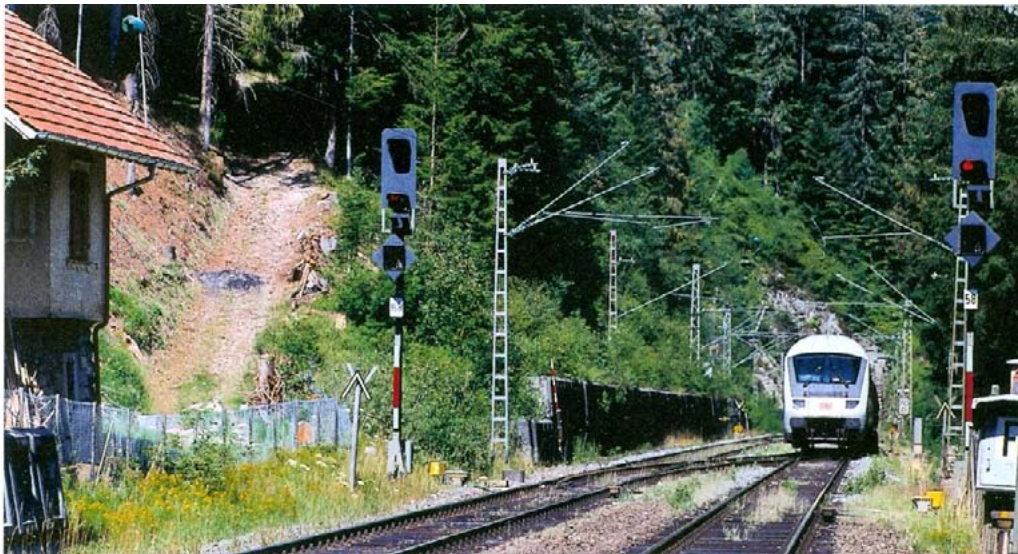
Voorbeeld Schwarzwaldbahn: inrijsein voor dubbele spoorwissel op een open spoor.
