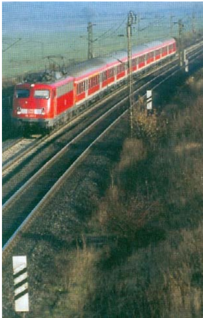
De voorseinbalken wijzen de machinist op een voorsein. Het is nog 250 m van het eerste bakens naar het voorsein. Het hoofdsein is echter nog niet te zien.
