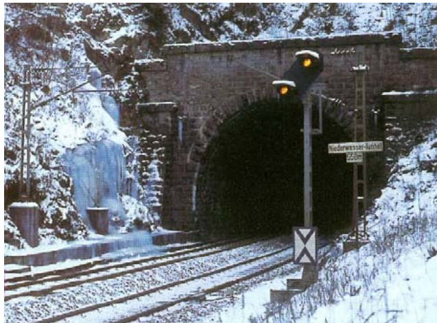
Een voorsein bij een tunnelingang van de "Schwarzwaldbahn" toont "stop verwachten". Tot aan het hoofdsein worden nog enkele tunnels en bogen voorbijgereden.
